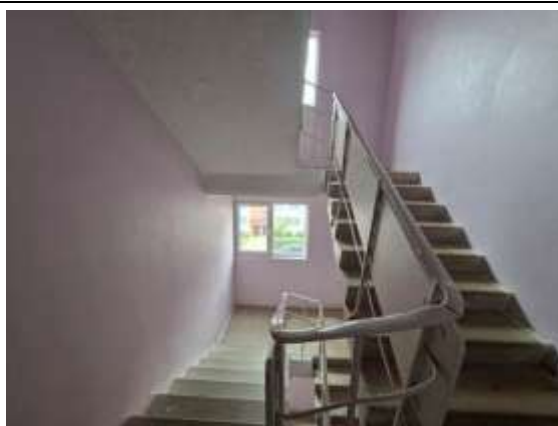
4.stāva kāpņu telpa
