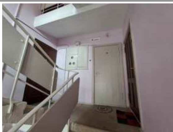
4.stāva kāpņu telpa
